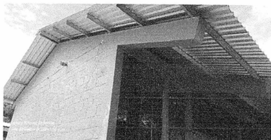
Foto 1: cubierta de las laminas terminada
